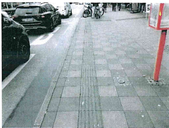
Foto einer „Bushaltestelle entlang der Fahrbahn mit Leitstreifen, getrenntem Warte- und Gehbereich“
